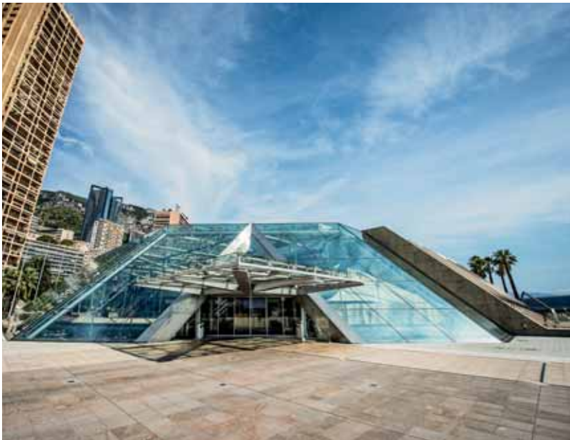
Nicht nur die Architektur des Grimaldi Forum überzeugt: Auch bei den inneren Werten punktet das Konferenzzentrum im Herzen Monacos mit Blick auf das Mittelmeer. Foto: Grimaldi Forum
