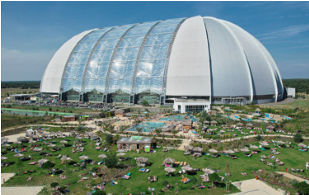
Der Dome des Tropical Islands erstreckt sich auf satten 66.000 qm. Unter der Kuppel finden Besucher eine tropische Badewelt, die sich allerdings auch im MICE-Bereich sehr gut bespielen lässt. Fotos: Tropical Islands
